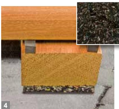
4 Gummi reguliert: Höhenausgleich-Pads für die Unterkonstruktion.
