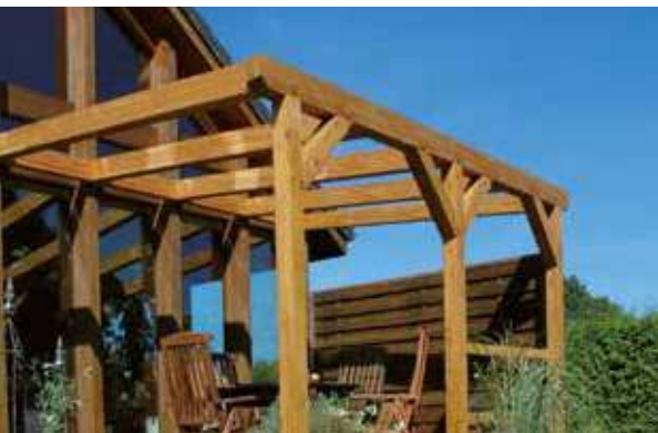
Terrassendach aus Lärchen-Leimholz
