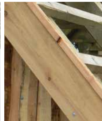
Lärchen – Dachstuhl im Detail
