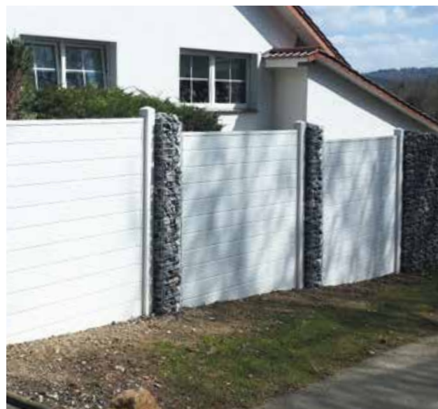
Fix mit Gabionen-Elementen, vom Kunden bauseits in der Höhe angepasst
