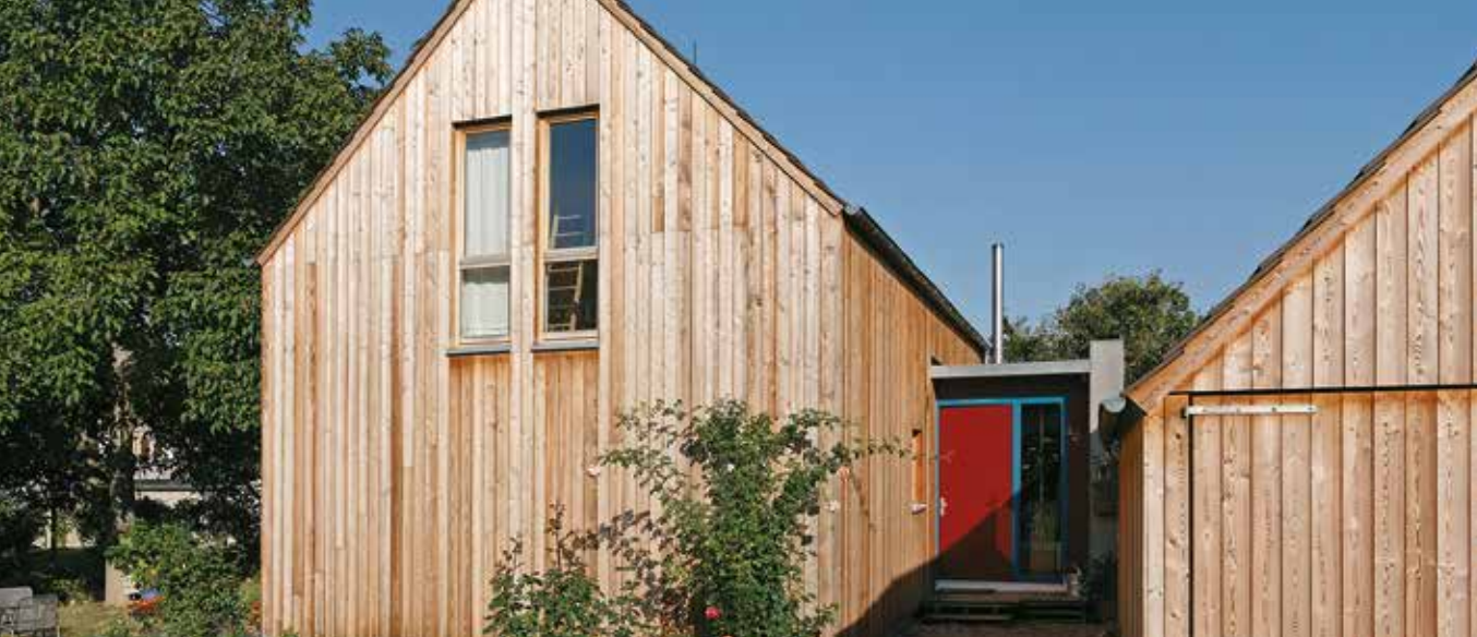
Moderne Fassadengestaltung mit Lärchenholz
