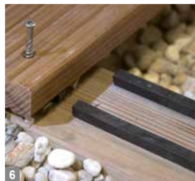
6 Praktisch: selbstklebendes Ausgleichsband reguliert Unebenheiten.
