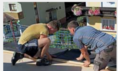
2. Die Verlegung der STEICOsafe erfolgt fortlaufend im Verband.
