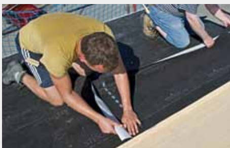
3. Bei jeder folgenden Reihe ist auf einen Versatz von 25 cm im T-Stoßbereich achten.
