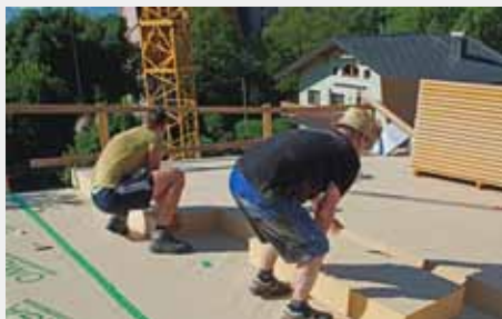
1. Vorarbeiten: Vollflächige Verlegung von STEICOtherm dry auf einer Dampfbremssolie.
