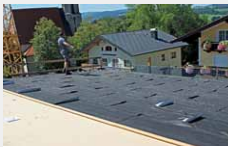
4. Durch einfaches Handling der STEICOsafe lassen sich in kurzer Zeit sehr große Dachflächen realisieren.
