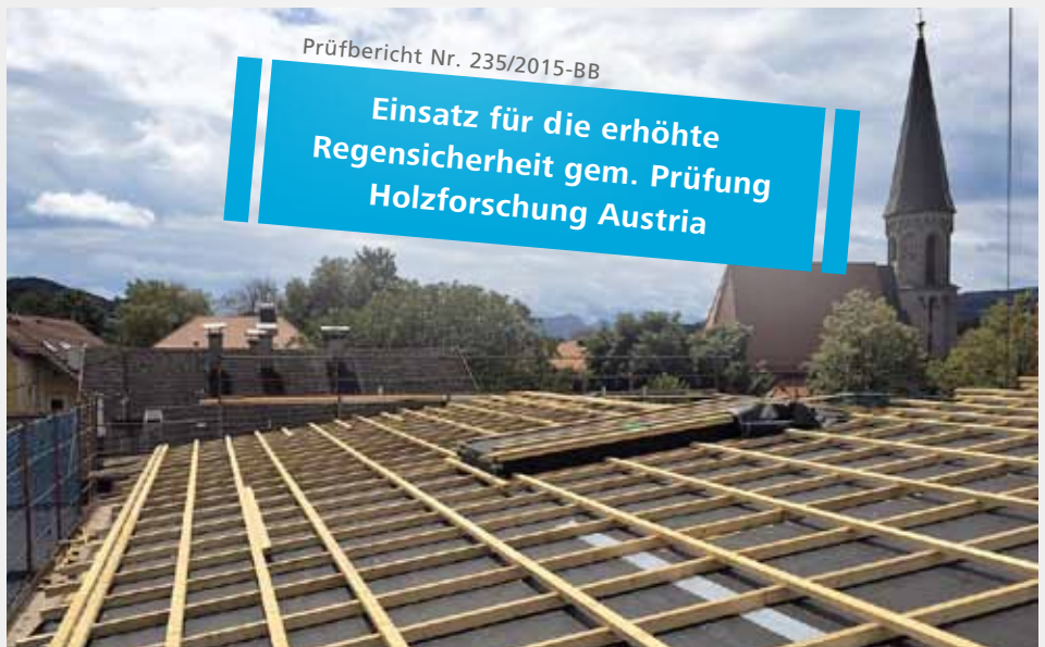
Die fertige Unterdachkonstruktion: STEICOsafe mit Lattung
