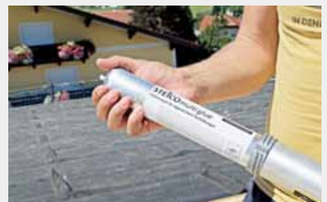
5. Nach Verlegung des Daches mit STEICOsafe beginnt das Verkleben der Überlappungsbereiche der Unterdeckbahn mit STEICOmulti glue.
